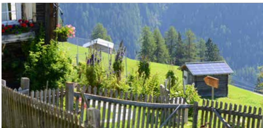
Solaranlagen an Nebengebäuden
