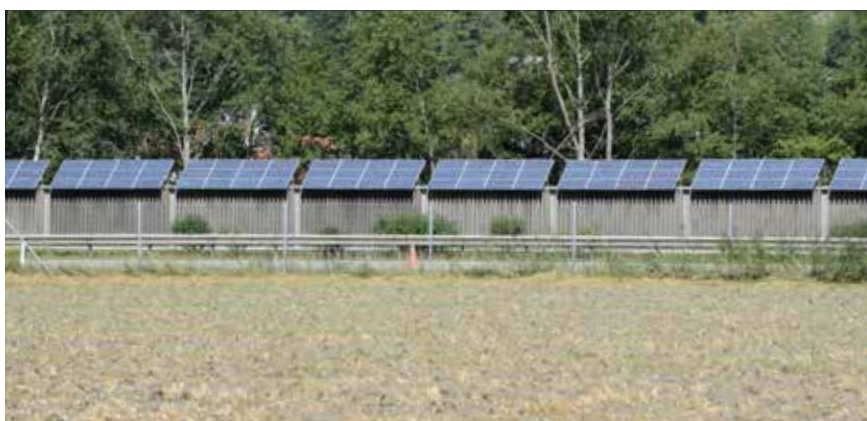
Solaranlagen auf Anlagen Foto z.B. Schallschutzwand Domat Ems
