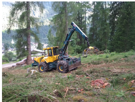
Rodungsarbeiten für das neue Reservoir
