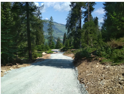
Zufahrtsstrasse zum neuen Reservoir
