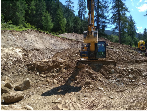
Baugrubenaushub für das neue Reservoir
