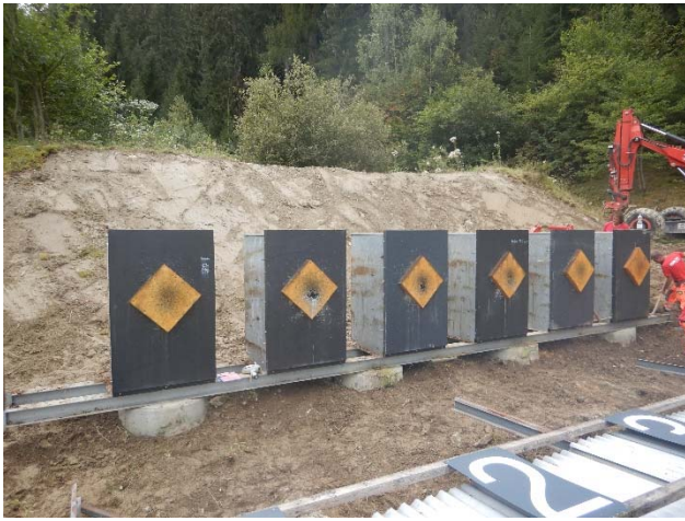
Foto: Arbeiten Erdreichsanierung
